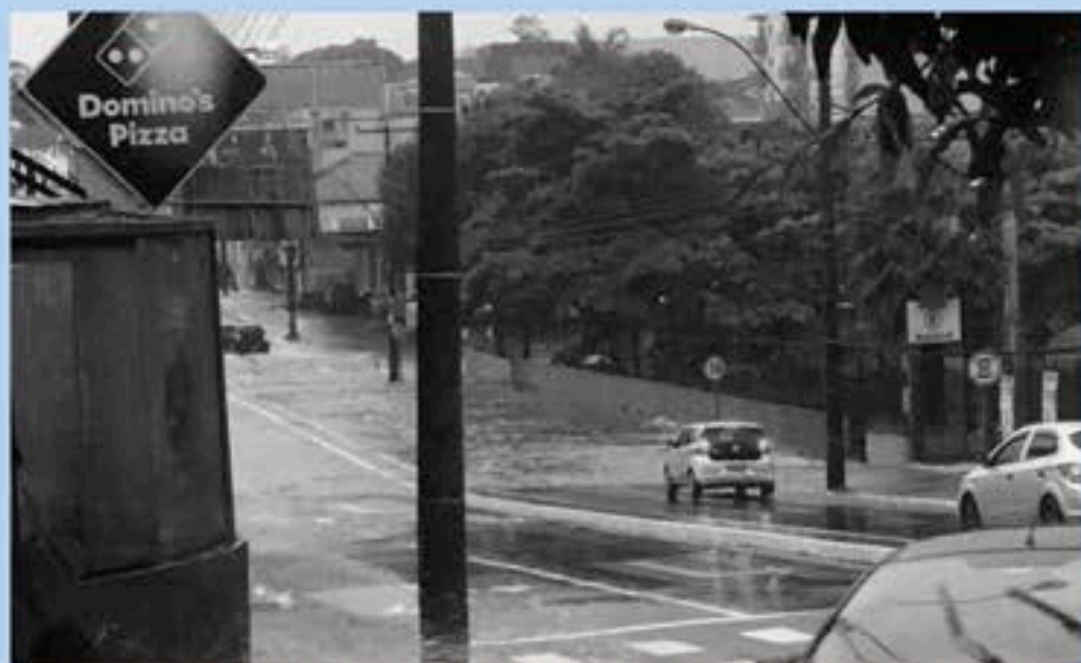
Figura 17 - Alagamento do pontilhão da Avenida São Carlos (2020).
