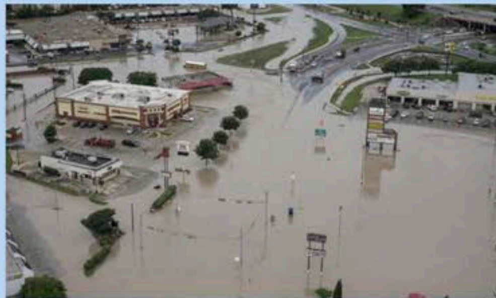
Figura 7 - Inundação em San Marcos, Texas.
