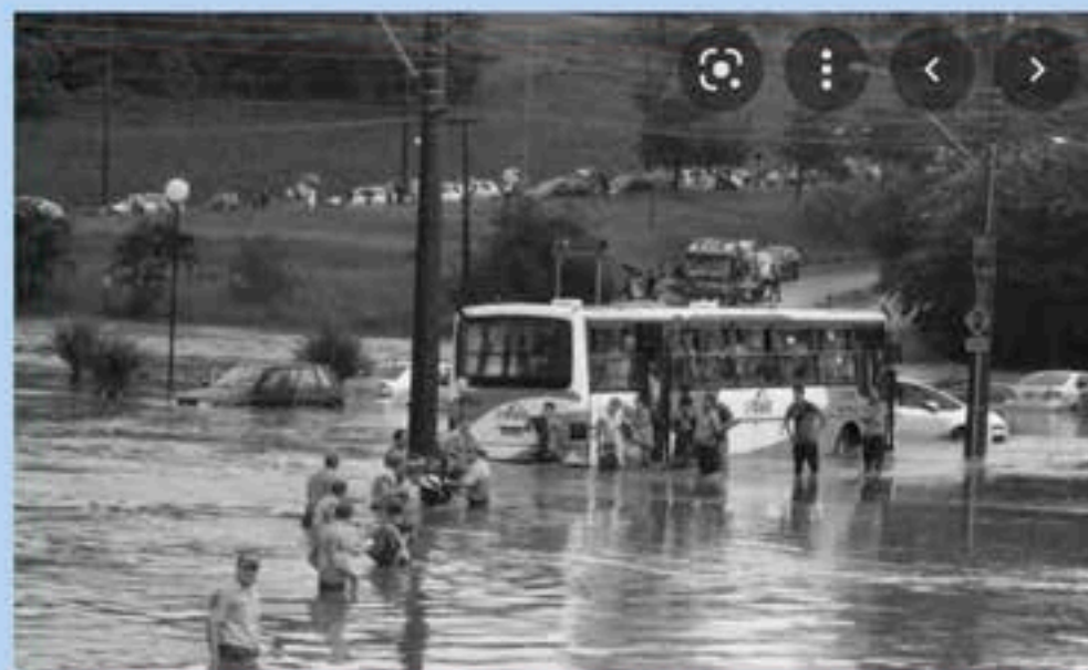
Figura 20 - Enchente na Rotatória do Cristo, segundo ponto mais crítico da cidade (2011).
